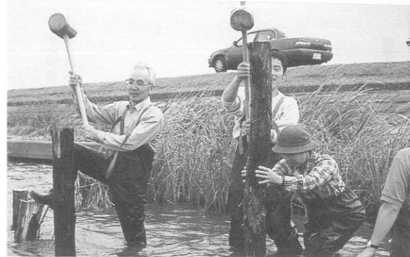
市民による杭の打ち込み作業（一九九五年一〇月、霞ヶ浦高浜入にて。撮影／飯島博）
