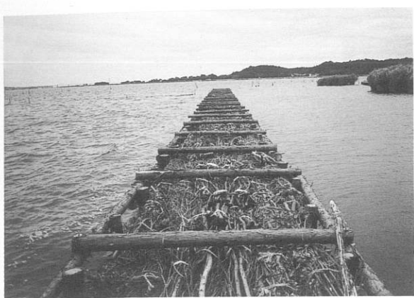
霞ヶ浦に設置された粗朶消波堤。流域の間伐材を利用している(撮影/飯島博)
