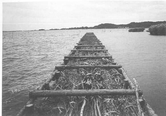
霞ヶ浦に設置された粗朶消波堤。流域の間伐材を利用して（撮影／飯島博）
