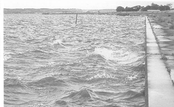
コンクリート護岸に打ち寄せる波(撮影/飯島博)
